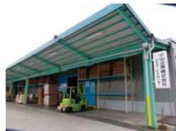
本社サービスセンター 小玉倉庫
