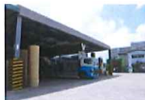
新菅南サービスセンター
