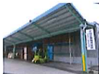
本社サービスセンター 小玉倉庫
